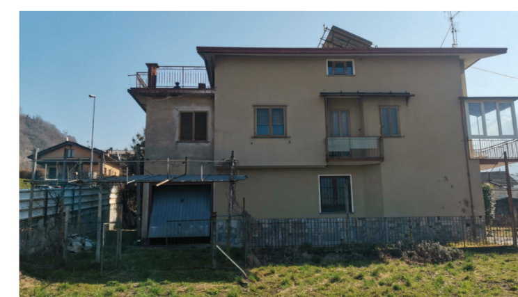
In queste foto, la vecchia casa
